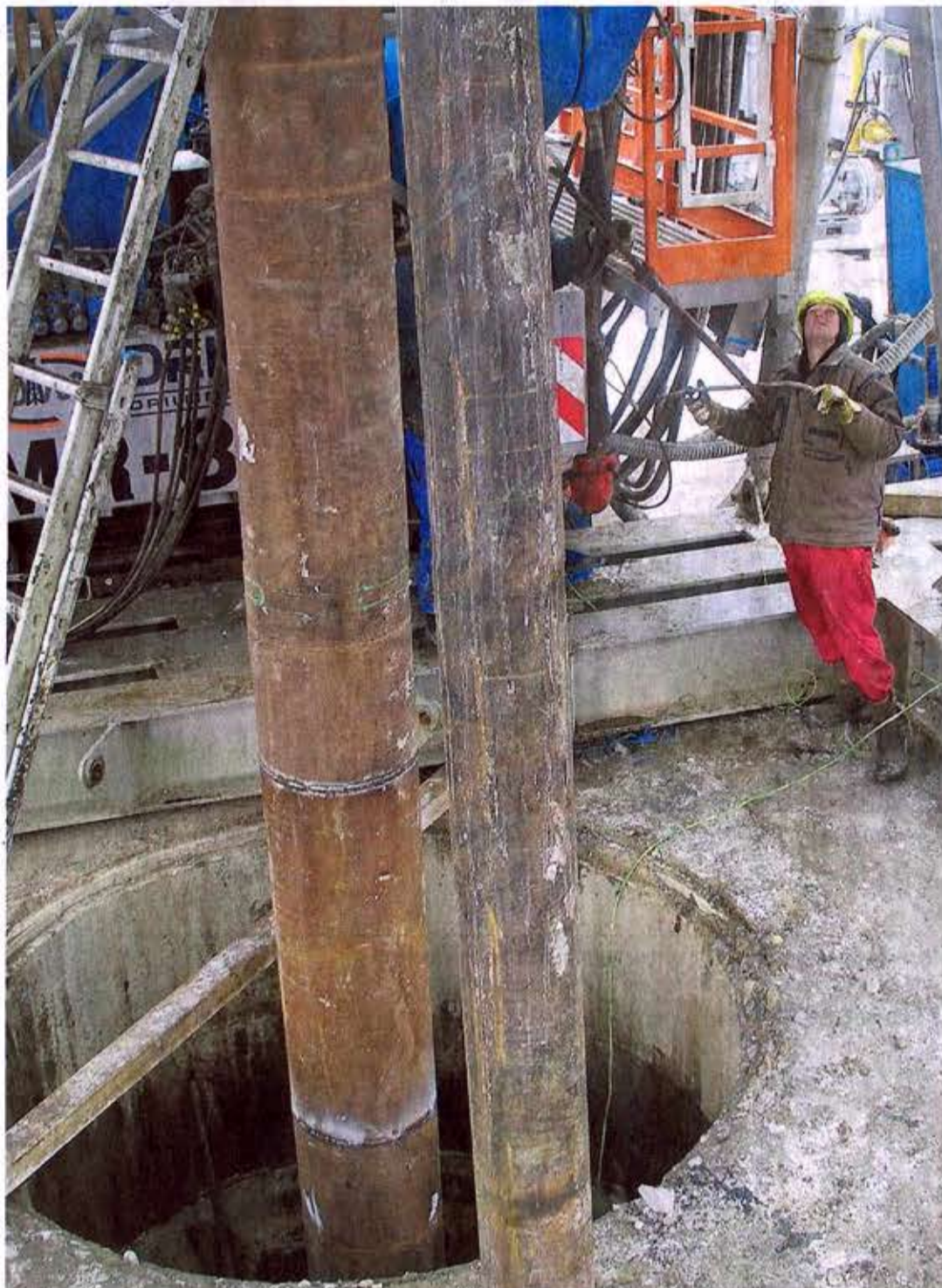
Bei der Firma Grob Gemüsebau in Schlattingen wurde erfolgreich nach Thermalwasser zum Beheizen von Gewächshäusern gebohrt.
