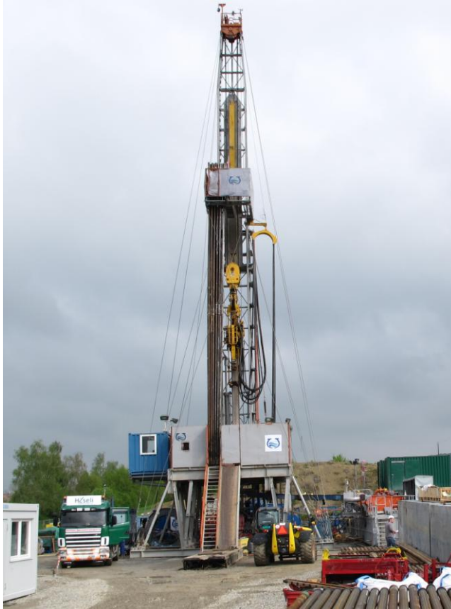
Abb. 2: Bohranlage MR 8000 in Schlattingen
