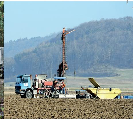
Bohrgerät für eine Aufzeitbohrung
