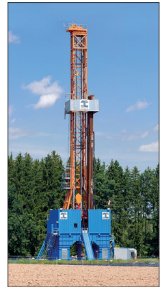
Liefert bald auch Strom: das Geothermie-Kraftwerk Taufkirchen.
