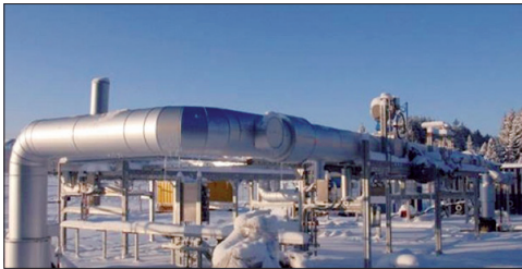
Wohlige Wärme für den Winter: das Geothermie-Kraftwerk Grünwald.
