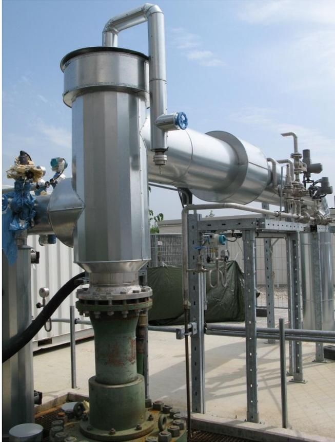
Figur 5: Brunnenkopf des Geothermie-Kraftwerks Unterhaching, Südbayern. Die Gesamthöhe beträgt ca. 3 m.
