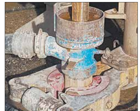
ABTEUFEN. In Kreuzlingen wurden die Bohrungen auf 200 Meter Tiefe abgeteuft.
