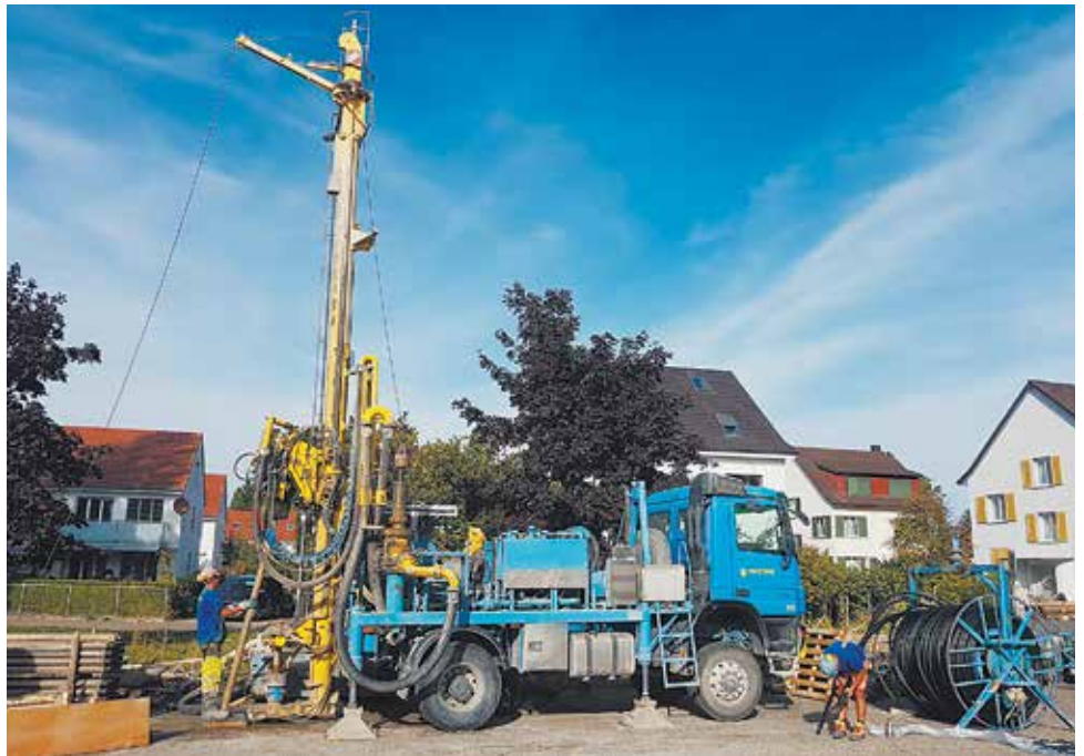
SCHWERES GERÄT. Eines von zwei Bohrgeräten in Kreuzlingen.
